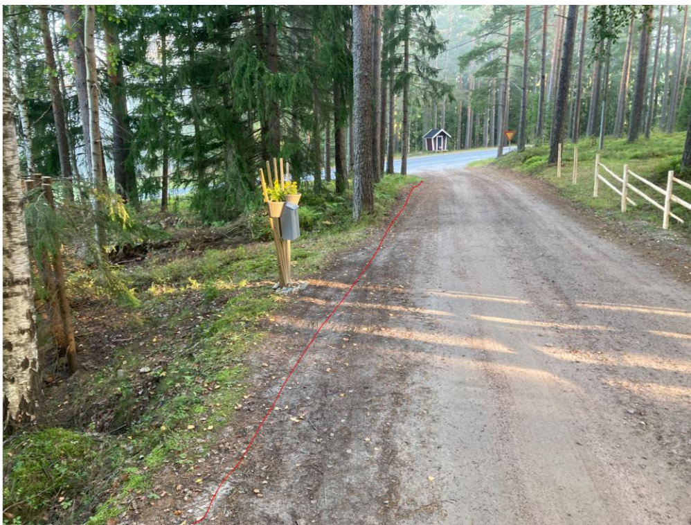
BILD 17 AMIRALTORPSVÄGEN: HÄR BLEV 192-TRÅDARS FIBERKABELN NERPLOGAD FÖR NÅGON VECKA SEDAN. DEN GÅR TILL ALLA ANSLUTNINGAR I VÄTTLAX, ORVLAX OCH PADVA. SYNS DET?
