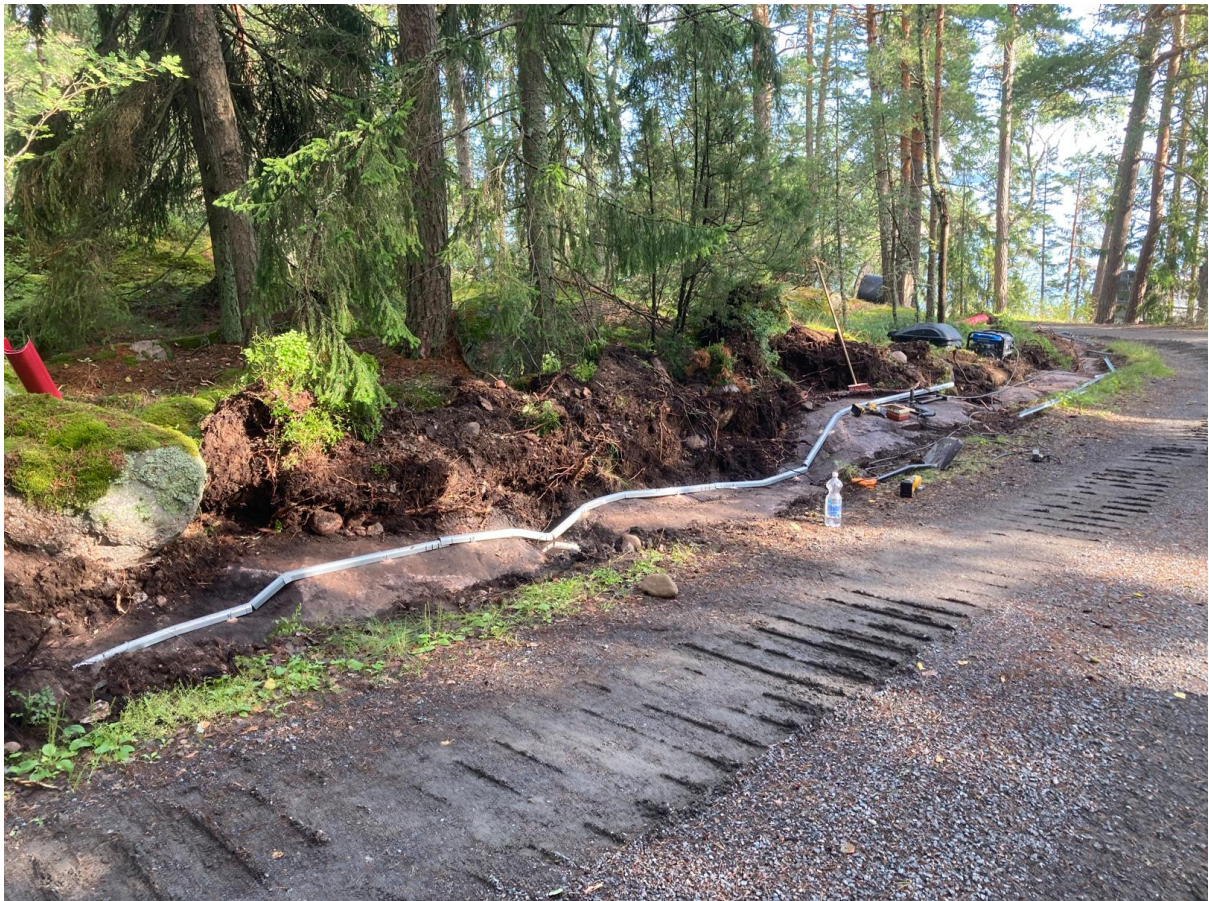
BILD 16 ÖVÄGEN UNDER ARBETE.
