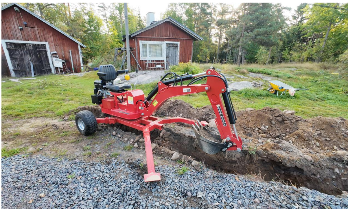
BILD 6 FASTIGHETSÄGARE PÅ KALVDALSVÄGEN GRÄVER FIBER.
